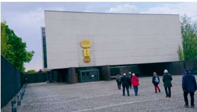
Fassade über dem Feierhof
